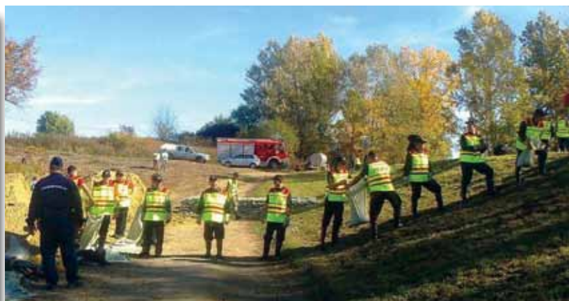
Gradnja „zečjeg nasipa“ na mađarskom tlu
